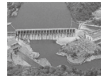
鹿瀬発電所全景▶P.25
