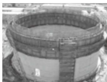
建設中の低温LPGタンク▶P.15
