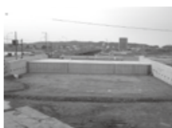
完成した函渠▶P.23
