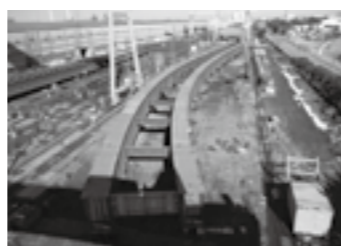
鋼桁仮組立状況▶P.7
